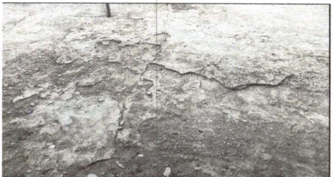
Foto 4: Reparación de planchas de concreto de patio.
