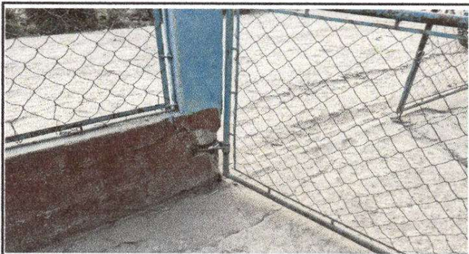
Foto 3: Reparación de tubo hg y malla galvanizada.
