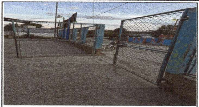
Foto 2: Sustitución de malla a portón de baranda de metal.
