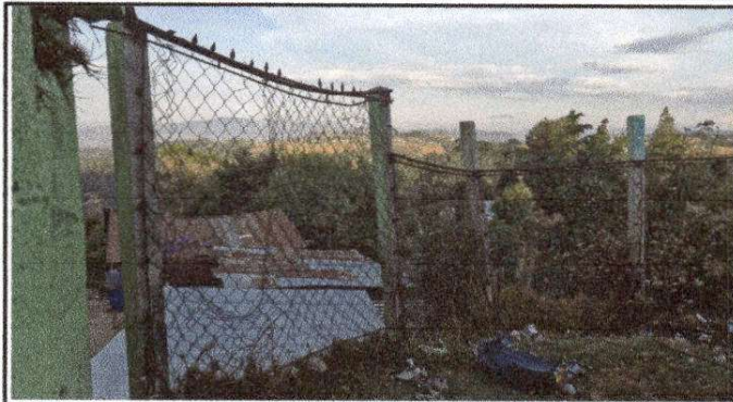
Foto 1: Reparación de tubo hg y malla galvanizada.
